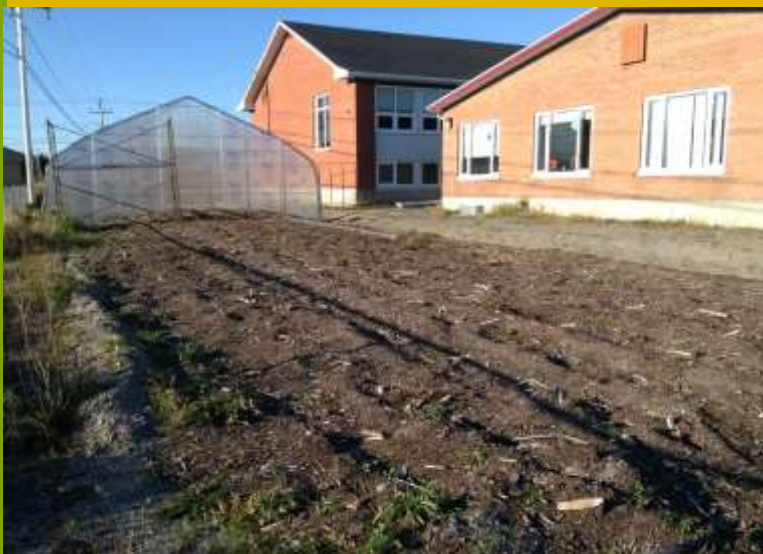
Construction d'une serre à l'école de Longue-Pointe-de-Mingan, Côte-Nord
